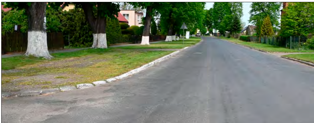
» Suliszewo, ul. Zwycięstwa przed przebudową.
