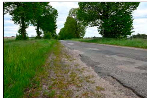
» Słonicie-Rakowo, przed przebudową.
