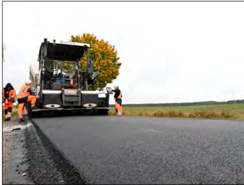
» Ostromęcko - Kolsk: w trakcie remontu.
