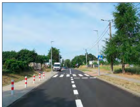
» Krzęcin - Granowo, po remoncie.
