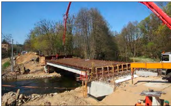
» Most w Barnimiu, w trakcie przebudowy.
