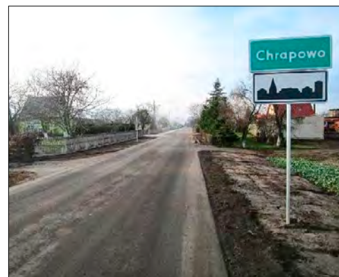
» Stawin - Chrapowo po przebudowie.
