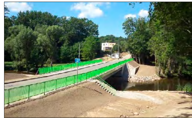
» Most w Barnimiu, po przebudowie.
