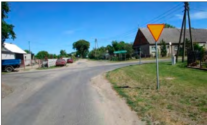
» Sławęcin przed przebudową.
