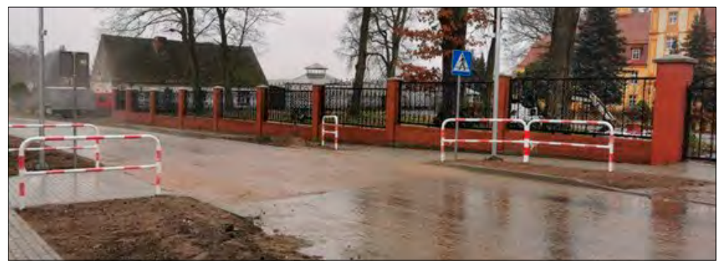
» Modernizacja i doposażenie przejścia dla pieszych w m. Brzeziny po przebudowie.
