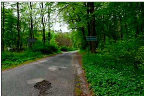
» Bogdanka - Sitnica - przed przebudową.
