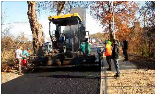
» Sławęcin w trakcie przebudowy.
