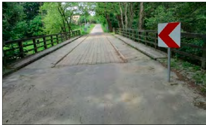
» Most w Barnimiu, przed przebudową.
