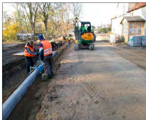
» Stawin - Chrapowo w trakcie przebudowy.
