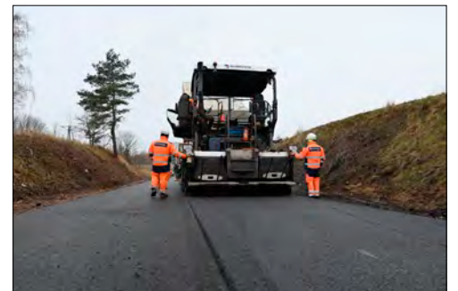
» Słonicie Rakowo, w trakcie przebudowy.
